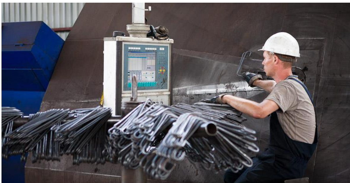
Рисунок 1. Производство заготовок арматурных каркасов на станке с ЧПУ [1]
