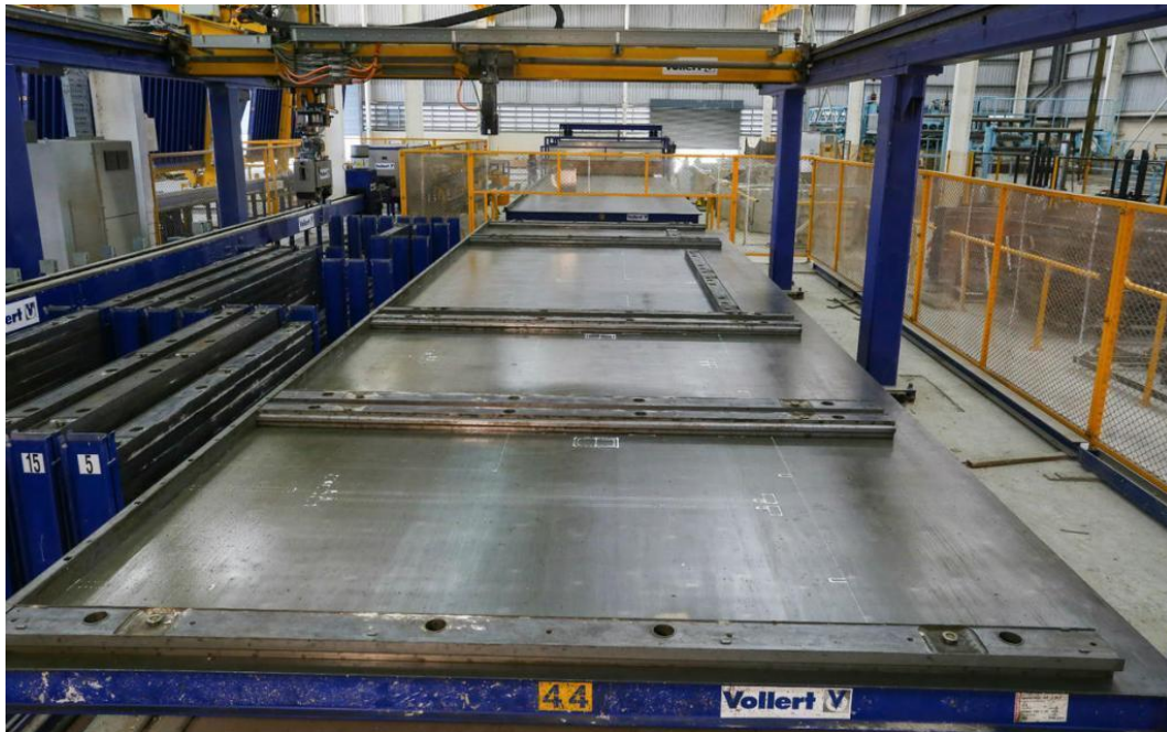
Рисунок 4. Автоматизированная линия подготовки опалубки [7] (справа и на заднем плане огорожена зона, в которой допускается присутствие людей)
